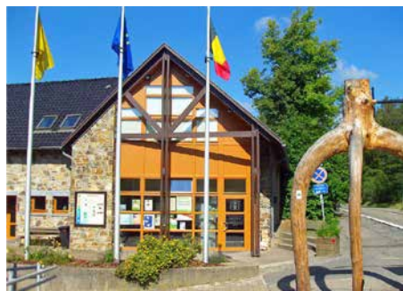
Le centre Nature de la Communauté germanophone, premier bâtiment public belge 100% autonome en énergie.
