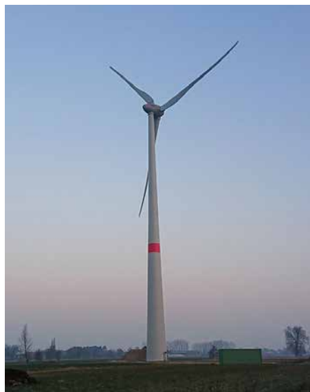
L'éolienne de Lochristi (2,35 MW), mise en service en novembre 2017.
