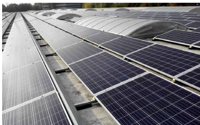
Installation de 925 panneaux photovoltaïques sur le toit de l'ASBL "Les Petits Riens"
