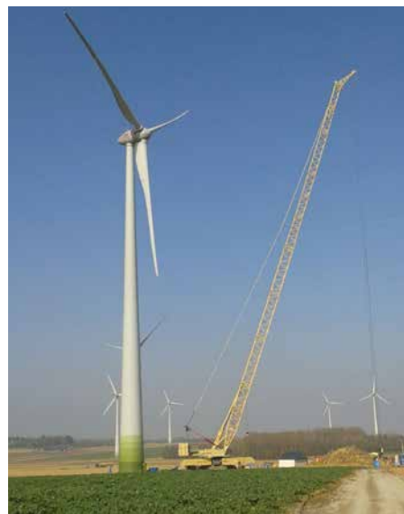
Trois nouvelles éoliennes ont été construites à Floreffe en 2017.
