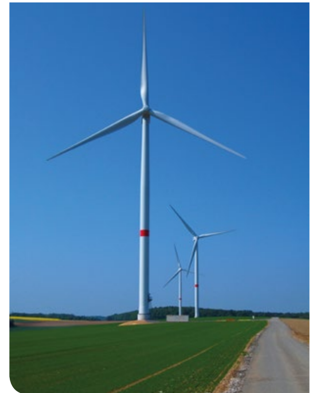
L'éolienne de Ciney 2 (3,2 MW) a été mise en service en avril 2016.
