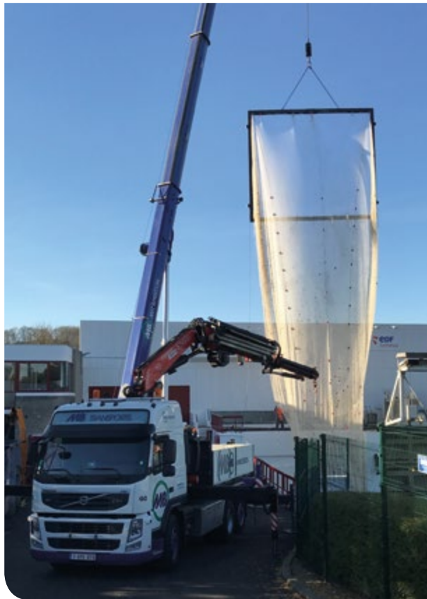
Grue et filet de récupération utilisés pour le début des études Life 4 Fish le 2 décembre 2016 - centrale hydro-électrique d'Andenne.
