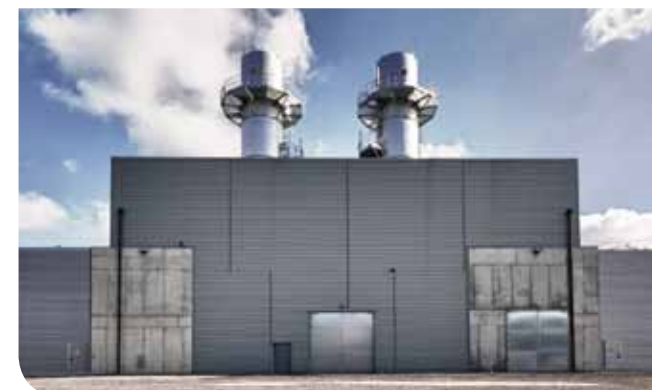
La quatrième unité du site d'Angleur, construite en 2010, est une centrale à cycle ouvert de deux fois 63 MW qui peut atteindre sa pleine puissance en moins de dix minutes, grâce à une faible inertie thermique. Cette centrale dite « de pointe » peut couvrir les pics de consommation de 70 000 foyers.
