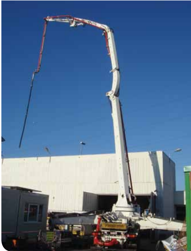
Rénovation de la centrale hydroélectrique de Lixhe, décembre 2013 : la machine à béton va être mise en marche pour reconstruire le conduit hydraulique aval. La rénovation de cette centrale a mobilisé 4 millions d'euro en 2013, sur un total prévu de 12 millions sur deux ans.
