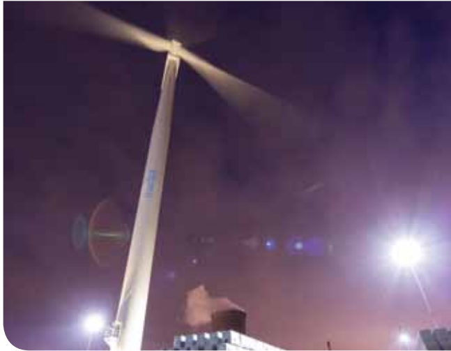
L'éolienne inaugurée en décembre 2013 sur le site de Marlux. Celle-ci est opérationnelle depuis novembre 2013.
