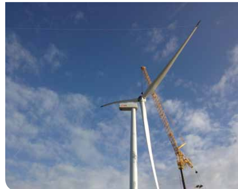
Construction de l'éolienne du site de Marlux.
