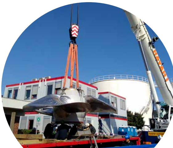
Déchargement du rotor d'une des nouvelles turbines, sur site.
