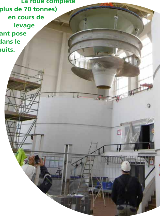
Déchargement du rotor d'une des nouvelles turbines, sur site.
