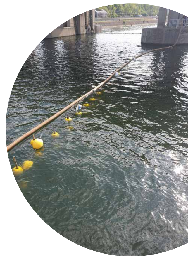
Installation de la barrière de dissuasion électrique en amont de la centrale hydroélectrique de Grands-Malades
