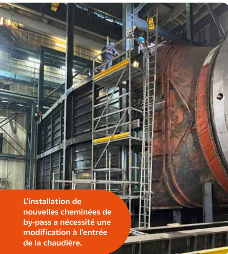
L'installation de nouvelles cheminées de by-pass a nécessité une modification à l'entrée de la chaudière.
