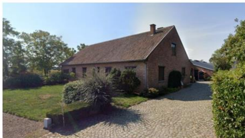
Figuur 13: Gebouw AE
