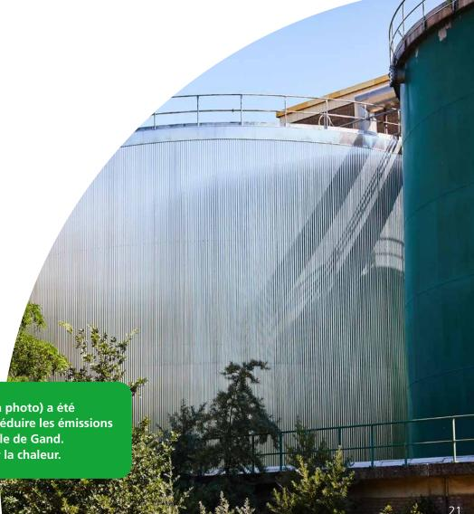
Une ancienne cuve de stockage de fuel lourd (au milieu de la photo) a été transformée en installation de stockage d'eau chaude pour réduire les émissions liées à l'alimentation du réseau de chauffage urbain de la ville de Gand. Une paroi isolante extérieure entoure la cuve pour préserver la chaleur.
