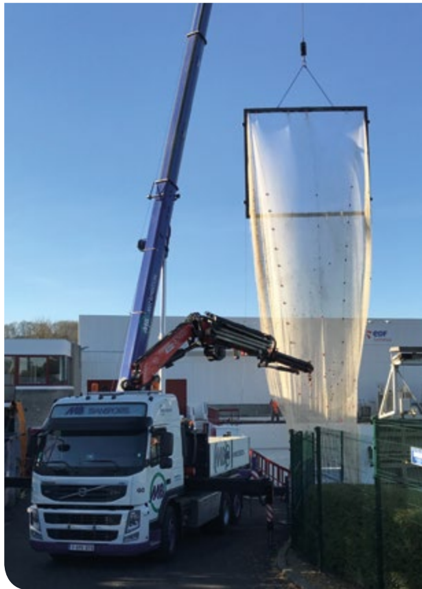
Gebruikte kraan en recuperatienet voor de aanvang van de Life 4 Fish-studies op 2 december 2016 – waterkrachtcentrale van Andenne.
