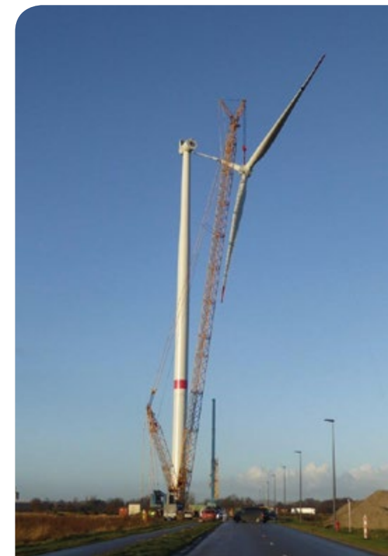
Bouw van één van de 4 windturbines van het park van Rieme-Noord.
