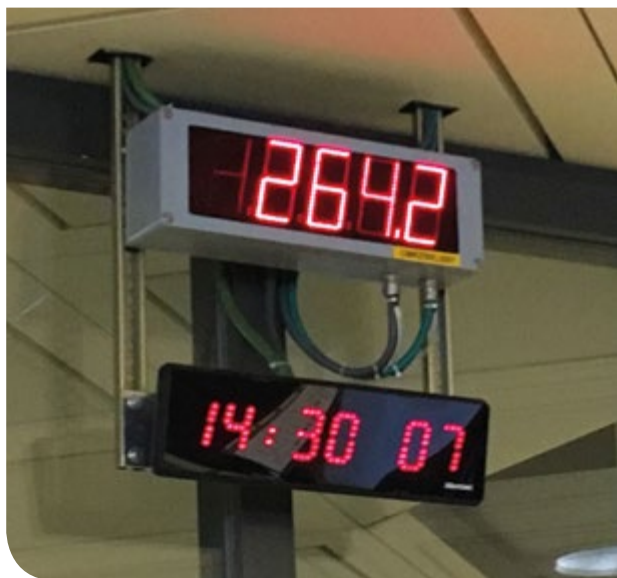
264 MW elektrisch vermogen geproduceerd om 14.30 uur.
